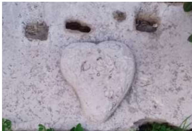
Fig. 22: Particolare stemma di Corato, resti soglia del vecchio Macello (1862-2007).
